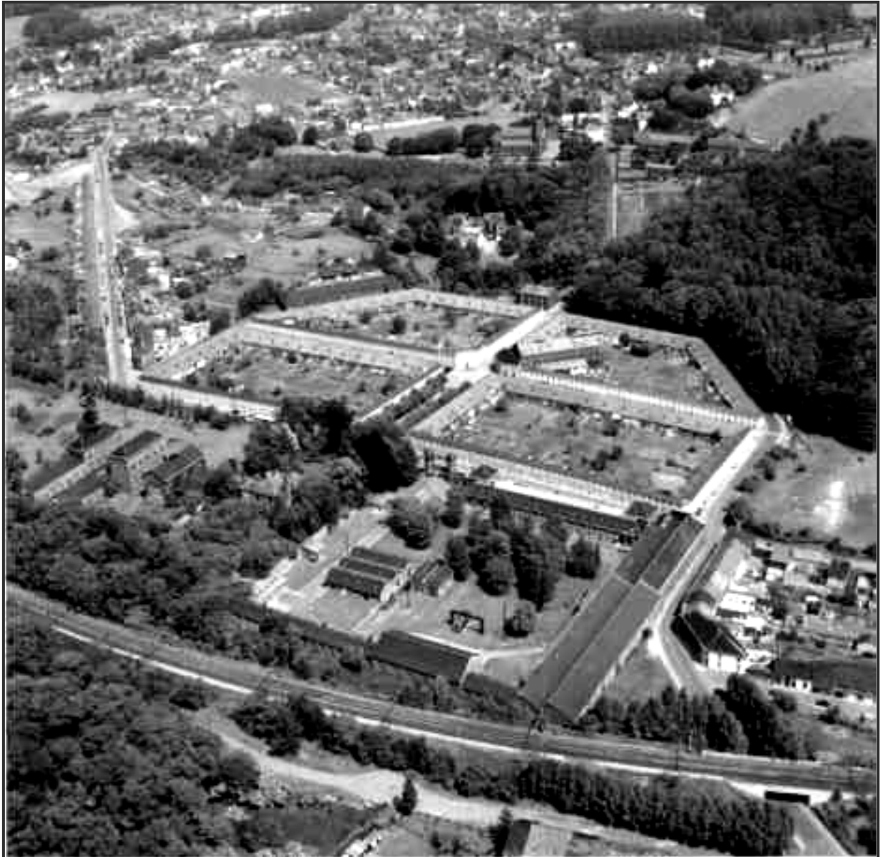
Document 4 : Photo aérienne du site du Bois-du-Luc © Ecomusée du Bois-du-Luc
